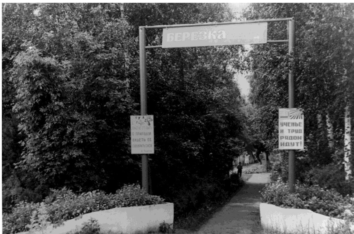
Въезд в производственный лагерь «Березка»
